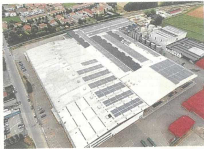
L'impianto fotovoltaico sullo stabilimento di Gambettola. Con l'integrazione dei nuovi pannelli il gruppo arriverà ad autoprodurre 2,5 megawatt.
